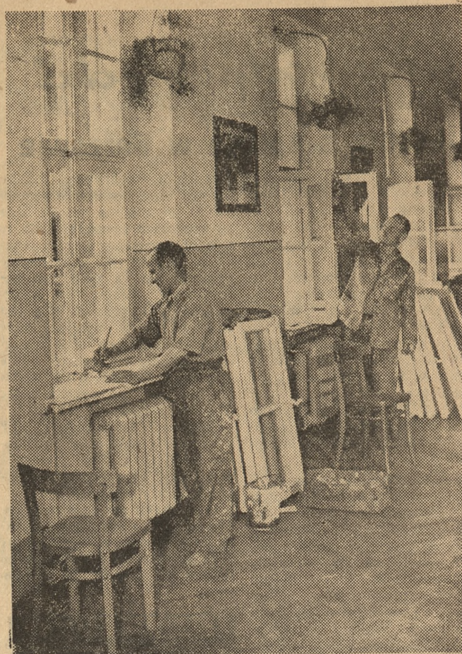
W opustoszałych salach szkolnych wre praca. Na terenie całej Polski prowadzone są intensywne prace remontowe na przyjęcie młodzieży szkolnej. Grupa Miejskiego Przedsiębiorstwa Remontowo-Budowlanego w Warszawie, remontująca szkoły podjęła zobowiązanie wykonania 200 proc. normy w ramach Czynu Lipcowego. Na zdjęciu: Fragment prac remontowych. CAF fot. Dąbrowiecki
