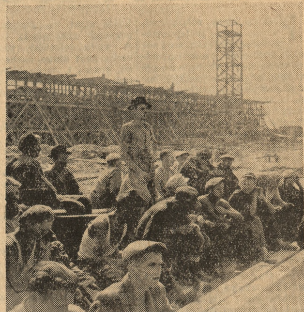
CAF fot. Zygm. Wdowiński Odpowiadając na apel huty „Kościszko” załoga zatrudniona przy budowie hali nr 7 Fabryki samochodów ciężarowych podjęła zobowiązanie zespołowe oddać halę nr 7 — 4 dni przed terminem przewidzianym harmonogramem. Na zdjęciu: Fragment masówki, na której podjęto zobowiązania
