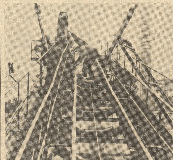
W elektrowni „Jaworzno III” trwają prace przy drugim turbozespolu, który będzie uruchomiony w I kwartale przyszłego roku. Na zdjęciu: montaż jednego z urządzeń. Fot. — CAF
