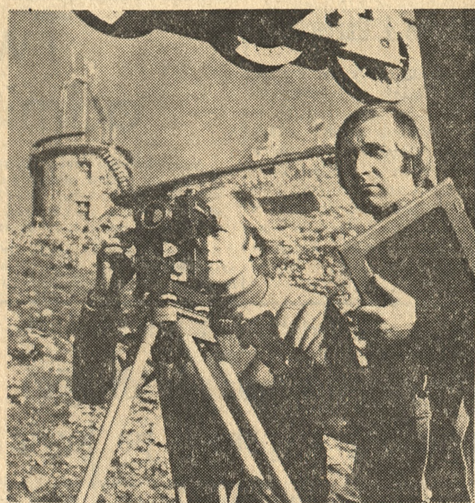
A. Szumilas i T. Mroczek, geodeci z krakowskiego Przedsiębiorstwa Geologiczno-Fizjograficznego i Geodezji Budownictwa „Geoprojekt” prowadzą w Tatrach ciekawe badania. Dokonują oni pomiarów pionowości, osiowości i przesunień podpór wyciągu linowego z Hali Goryczkowej na Kasprowy Wierch. Na zdjęciu: młodzi geodeci podczas wykonywania badań w Tatrach.
