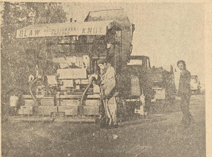
Nie tylko wygodniej, ale nade wszystko bezpieczniej będzie można poruszać się na zmodernizowanej jezdni w rejonie Wągrowca (woj. pł.) Ekipy drogowe prowadzą w tym rejonie prace, poszerzając m. in. jezdnię. Zwracają uwagę na właściwy profil drogi na łukach i krzyżówkach. Roboty wykonywane są przy użyciu najnowocześniejszego sprzętu importowanego z Anglii. (za) Fot. H. Kamza
