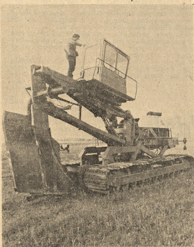
400 melioratorów układa w ciągu godziny holenderską maszyną TIEL, należąca do przedsięwzięcia melioracyjnego w Koninie. 5 brygad z Konina pracuje na obszarze 1000 ha gospodarstw indywidualnych w rejonie Kola. Założy tu około 1000 km drenów. TIEL sterowany jest laserem; pracuje dzięki temu z ogromną precyzją.
