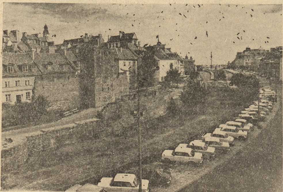
Dziś mury obronne chronią warszawskie Stare Miasto jedynie przed motoryzacją. Fot. — CAF
