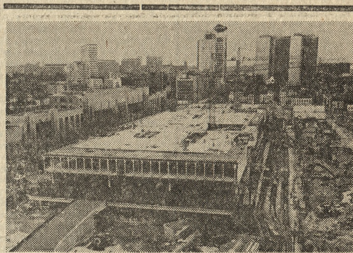
Brusela — pierwsze kondygnacje wielkiej budowli, powstającej przy Gare du Nord (z lewej). Pomieści ona stację metra, dworzec autobusowy oraz liczne biura.
