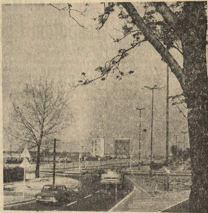
Początek przebudowanego i zmodernizowanego odcinka zachodniego trasy E-8 w Poznaniu: skrzyżowanie ul. Dąbrowskiego z al. Polską.
