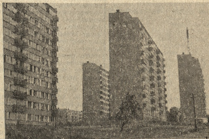
W panoramie Kalisza, coraz więcej jest osiedli mieszkaniowych. Na tych zaś przybywa systematycznie okazałe prezen- tujących się wieżowców. Wznoszą je brgady Kaliskiego Przedsiębiorstwa Budowlanego, które uznane zostało ostatnio za najlepiej pracujące w kraju. Fot. — S. Wiktor
