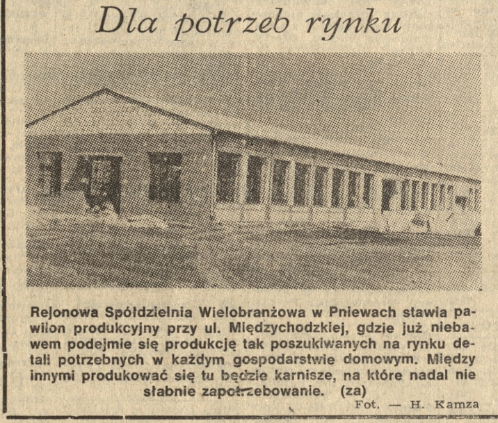
Rejonowa Spółdzielnia Wielobranżowa w Pniewach stawia pa wilon produkcyjny przy ul. Młedzychodzkiej, gdzie już nieba wem podejmie się produkcję tak poszukiwanych na rynku de talu potrzebnych w każdym gospodarstwie domowym. Między innymi produkować się tu będzie karnisze, na które nadal nie słabnie zapotrzebowanie. (za)
