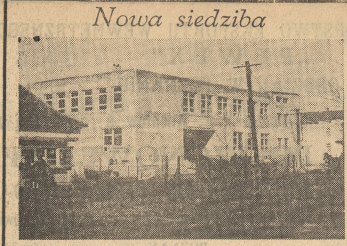
Trwa budowa nowej siedziby władz gminnych w Świnicach Warckich w województwie łódzkim. Obiekt jest już gotowy w stanie surowym a zakończenie prac ma nastąpić jeszcze w tym roku. Po przeprowadzce, w zajmowanym dotychczas przez Urząd Gminny budynku, otwarte zostanie po remoncie centrum kulturalno-oświatowe. Przewidziany jest tam m. in. klub rolnika i pomieszczenia szkolne. (woj) Fot. — W. Plutowski
