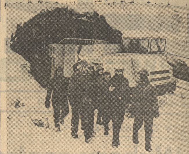
Na odcinku Tynda — Berkakit Bajkalsko-Amurskiej Magistrali Kolejowej buduje się pierwszy tunel, którego długość wyniesie 1234 metry. Na zdjęciu: brygada rebasey chodnikowych — zwycięzców we współzawodnictwie socjalistycznym na cześć XXV Zjazdu KPZR.
