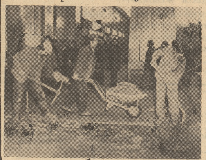
Trwają prace przy modernizacji gmachu Dworca Głównego PKP w Poznaniu. M. in. brygady Nowotarskich Zakładów Kamienia Budowlanego — Oddział Montażowy w Poznaniu, kontynuują wymanę zniszczonych płytek i układają nową posadzkę w holu. Wkrótce będą to czynić w innych pomieszczeniach dworcowych.
