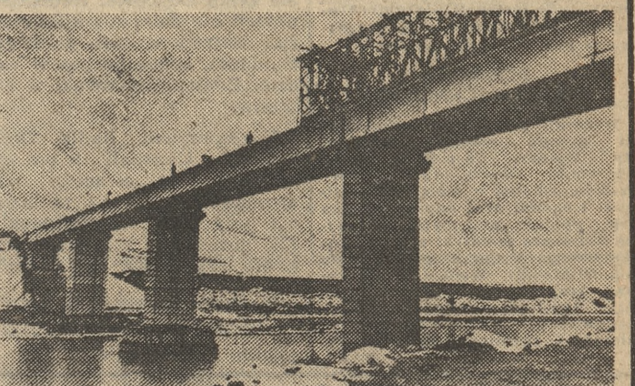
W szybkim tempie posuwają się prace na budowie największej w Kirgizji Toktogulskiej Elektrowni Wodnej. Na zdjęciu: końcowy montaż nowego mostu na rzece Naryn. Fot. — CAF
