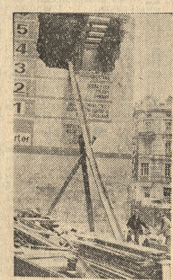
Na zdjęciu: prace rozbiórkowe domu przy „okrągłaku”.
