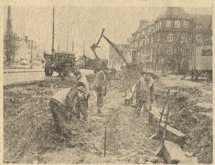
Prace trwają bez względu na pogodę. Fot. — H. Kamza
