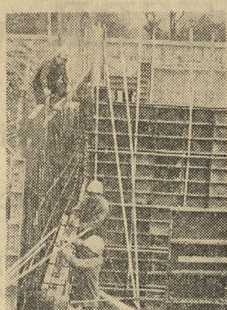
Na zdjęciu: mistrz budowy Kazimierz Jagielski nadzoruje roboty montażowe stalowych ścian szalowania. Fot. (2) — H. Kamza
