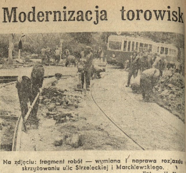
Na zdjęciu: fragmenty robót — wymiana i naprawa rozjazdu skrzyżowaniu ulic Sirzeleckiej i Marchewskiego. Fot. — H. Kamra
