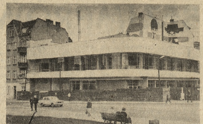
Budowa rzemieślniczego domu towarowego przy ul. Kościelnej w Poznaniu wkroczyła w końcową fazę. Wykonuje się ostatnie prace wykończeniowe i niebawem otworzy on podwoje. Już teraz prezentuje się okazale.
