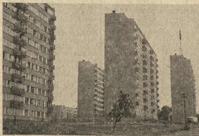
W panoramie Kalisza, coraz więcej jest osiedli mieszkaniowych. Na tych zaś przyszywa systematycznie okazale prezentujących się wieżowców. Wznoszą je bratki Kaliskiego Przedsiębiorstwa Budowlanego, które uznane zostało ostatnio za najlepiej pracujące w kraju. Fot. — S. Wiktor
