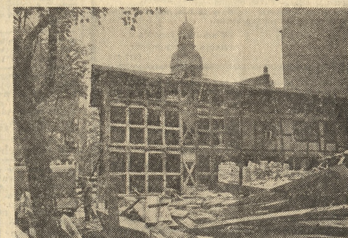
Stara rudera, stojąca nieopodal Rynku Wildeckiego przy narożniku ul. Czajczaj, doczekała wreszcie swego końca. Na zdjęciu — prace rozbiórkowe.
