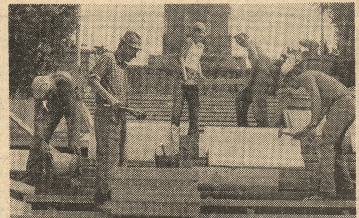
Brygady Ptaszka i Szewczyka przy montowaniu płyty schodo-wych.
