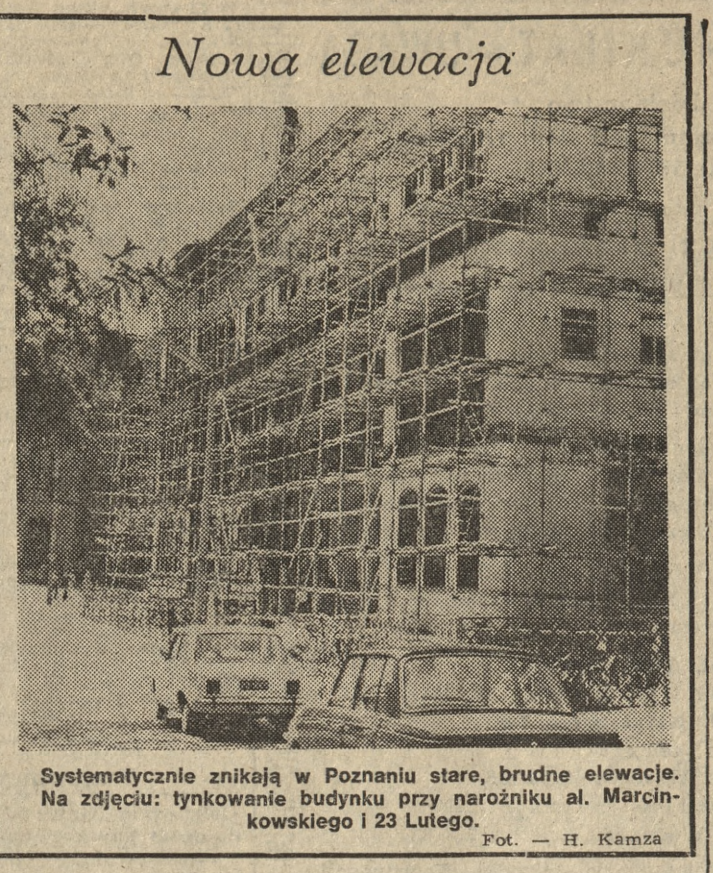
Systematycznie znikają w Poznaniu stare, brudne elewacje. Na zdjęciu: tynkowanie budynku przy narożniku al. Marcinkowskiego i 23 Lutego. Fot. — H. Kamza
