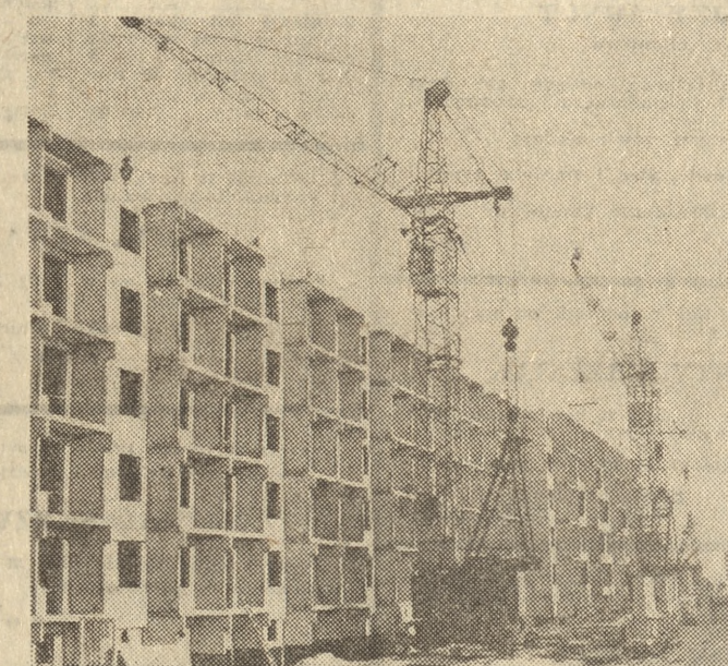
Prace przy budowie Osiedla Czecha na Ratajach nabierają rozmachu. Obecnie buduje się dwa bloki (do jednego z nich w niedługim czasie wprowadzi się ponad 100 rodzin). Równocześnie zakłada się fundamenty pod dwa następne.
