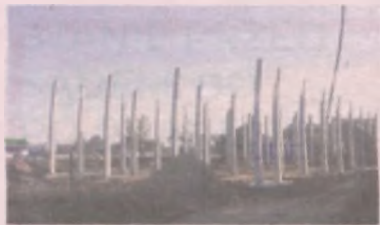
Budowa drugiego w Jarocinie marketu Media Expert postępuje dość szybko. Sklep będzie miał nieco ponad 880 m 2 powierzchni
