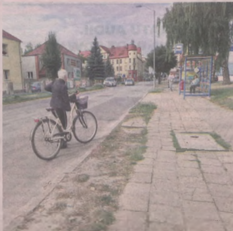
Chodnik przy ulicy Dąbrowskiego czeka na przebudowę
