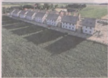
Budowa nowego osiedla w Potarzycy przebiega zgodnie z planem
