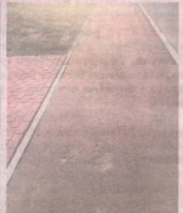
Tak wygląda odcinek drogi rowerowej. - To jest nowa inwestycja, a mamy mozaikę - mówi sołtys Potarzycy.
