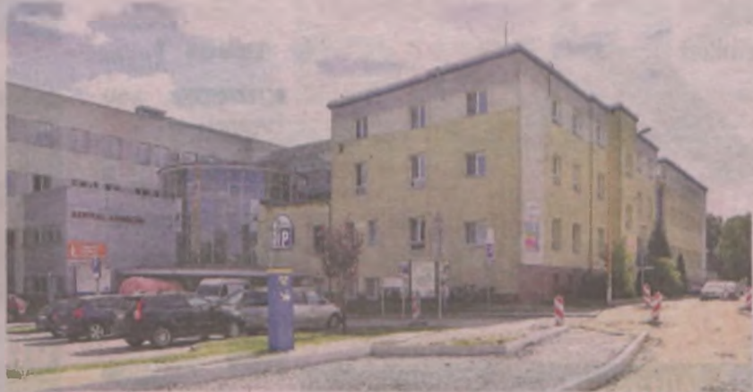
Ulica, która prowadzi do szpitala jest rozkopana z powodu prac, jakie są tam prowadzone w ramach rewitalizacji śródmieścia. Wykorzystując okazję lecznica chce się podłączyć do miejskiego ciepłownika
