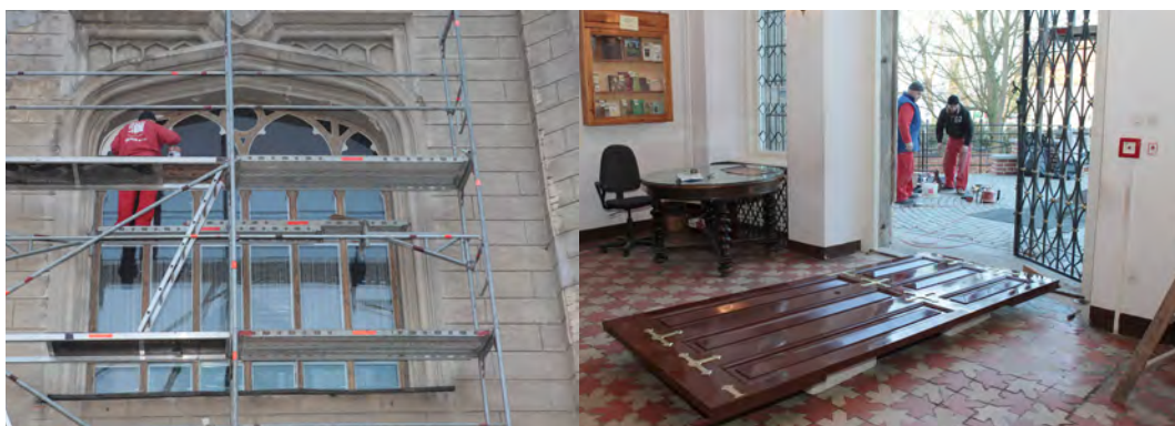
Il. 8. Rewaloryzacja i konserwacja stolarki w zamku kórnickim, 2012 r. Fot. Z. Nowakowski
