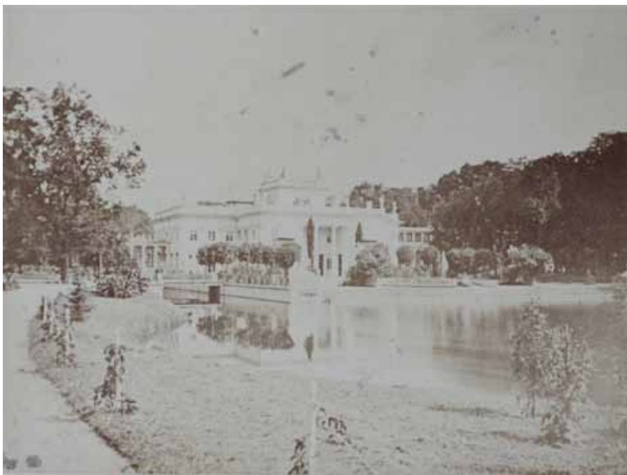
Fot. 7. Ciemne retusze na płowiejącej odbitce albuminowej przedstawiającej warszawskie Łazienki (sygn. III 821/17)
