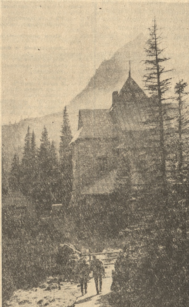
Położone niemal w środku polskich Tatr, na wysokości 1500 m schronisko „Murowaniec” (na zdjęciu) liczy już 50 lat. CAF – fot. – Momot
