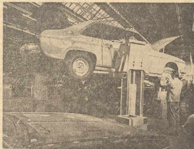
W zakładach „Tatra” w miejscowości Kopřivnice na Morawach (CSRS) rozpoczęto seryjną produkcję nowego modelu samochodu osobowego „Tatra 613” z 8-cylindrowym silnikiem, chłodzonym powietrzem.
