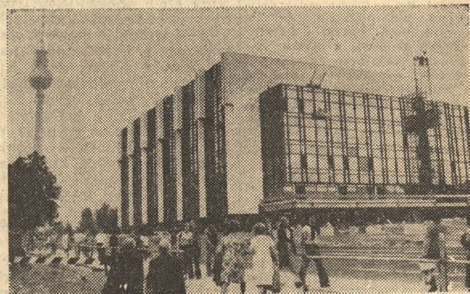
W centrum stolicy NRD — Berlinie dobiegają końca prace przy budowie Pałacu Republiki. Za pół roku otworzy on swe podwoje. Na zdjęciu — gmach Pałacu.
