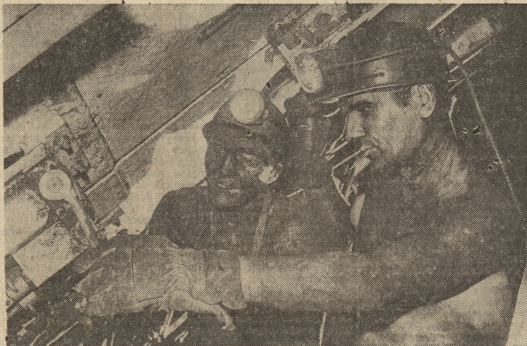
Jan Krasnodębski i Tadeusz Dutkiewicz, górnicy — przodowi Oddziału KG III, ściana VII — przy obudowie zmechanizowanej w kopalni „Dymitrow”.
