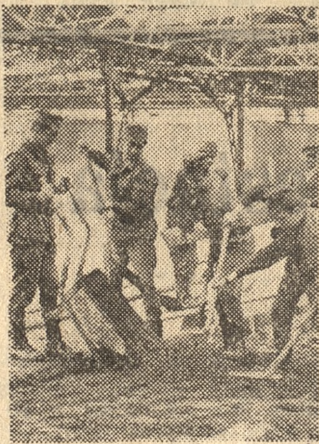
W Zakładach „Pomet” na Nowym Mieście uczestniczyli w czynie partyjnym żołnierze Garnizonu Poznańskiego, którzy pomagali przy budowie nowej hali obróbki mechanicznej.
