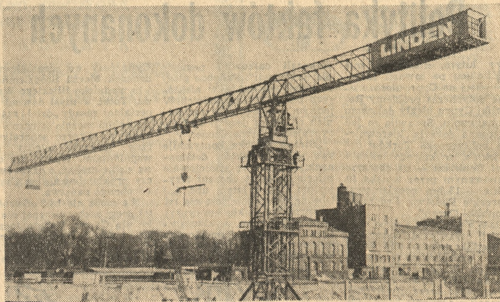
Przy stawianiu różnych obiektów używa się obecnie coraz nowocześniejszego sprzętu mechanicznego. Dotyczy to także dźwigów, przy pomocy których można budować coraz wyższe gmachy. Na zdjęciu: najnowocześniejszy żuraw na jednym z poznańskich placów budowlanych.
