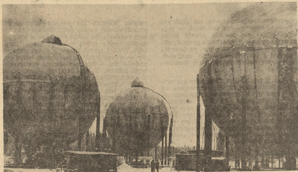
ZSR. W mieście Czajkowski, w obwodzie permskim, buduje się fabrykę kauczuku syntetycznego, jedną z największych w Kraju. Na zdjęciu: pierwsze obiekty fabryki — zbiorniki do przechowywania gazu.
