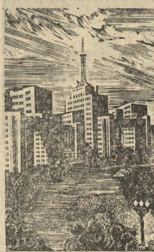
Charków — budownictwo wysokościowe.
