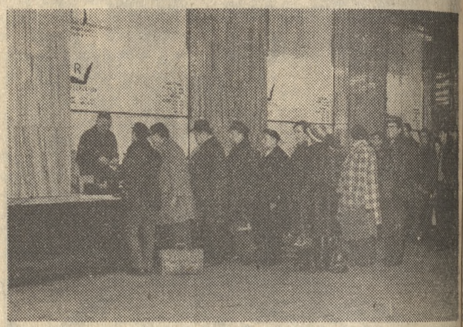
Chociaż prace przy modernizacji Dworca Głównego przebiegają w niełatwych warunkach, ponownie otwarto kasy biletowe w hallu głównym, co znacznie usprawniło obsługę podróżnych. Fot. — T. Fitzner
