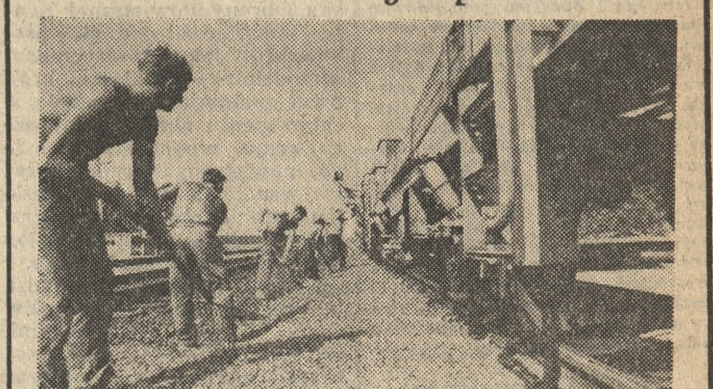
Warszawski pułk Obrony Terytorialnej im. Władysława Brońskiego w Siedlcach pomaga gospodarce narodowej w wielkich budowlach. Żołnierze pracują m. in. przy budowie Centralnej Magistrali Kolejowej (na zdjęciu). Pot. — CAF
