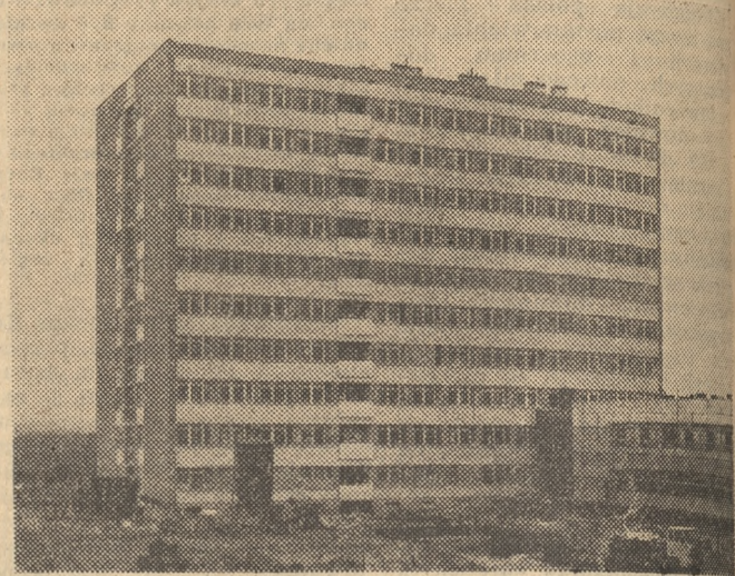
Na zewnątrz budynku prawie koniec prac. Elewacje są już gotowe.
