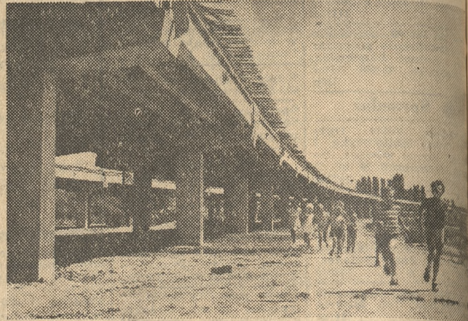
Na zdjęciu: estakada nie opodal ronda na Ratajach, która w nie dalekiej przyszłości nie tylko umożliwi bezkolizyjny przejazd jazdom, lecz także stanie się ładnym akcentem architektonicznym tego rejonu Poznania. Fot. — H. Kamza
