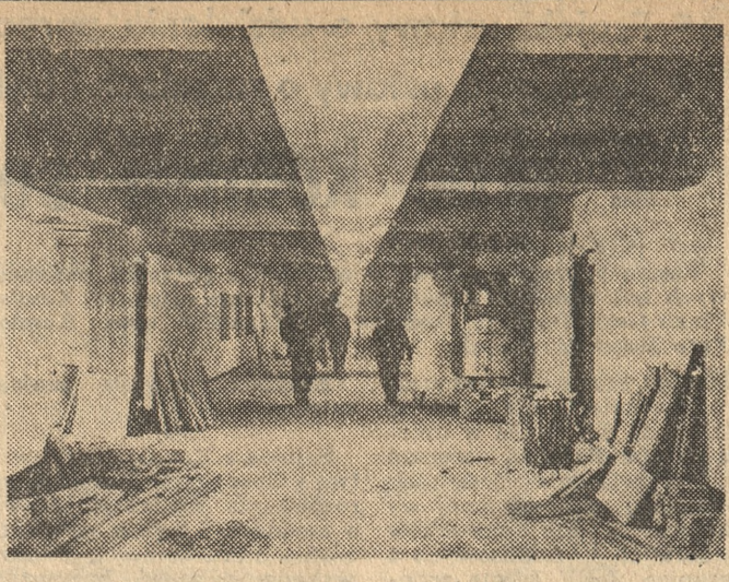
Na budowie Dworca Centralnego
