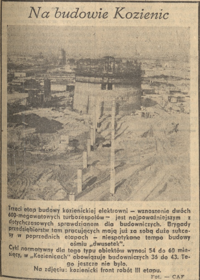
Trzeci etap budowy koziennickiej elektrowni — wznoszenie dwóch 600-megawatowych turbozespołów — jest najpoważniejszym z dotychczasowych sprawdzianem dla budowniczych. Brygady przedsiębiorstw tam pracujących mają już za sobą duże sukcesy w poprzednich etapach — niespotykane tempo budowy ośmiu „dwusetek”.
