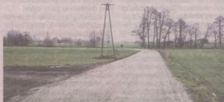
Ul. Krańcowa w miejscowościach Boguszyn i Boguszynek, to najdłuższy zmodernizowany odcinek dróg dojazdowych
