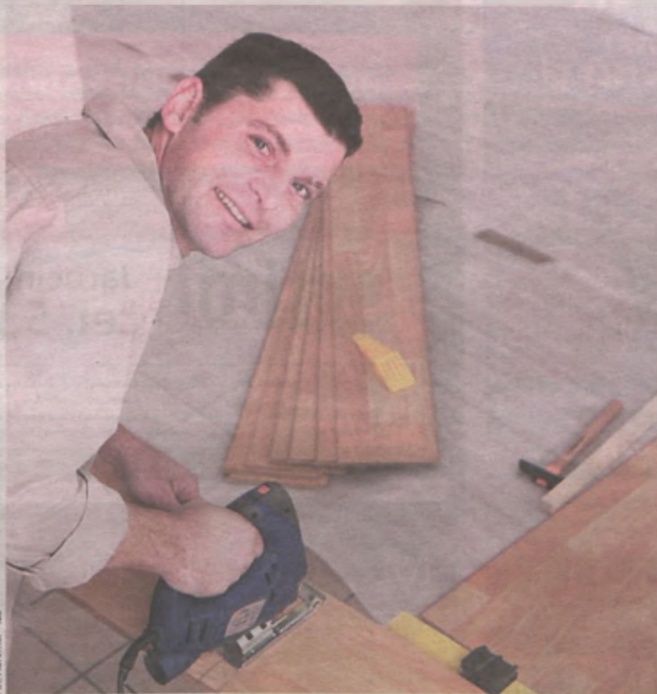
Producenci proponują różne sposoby montażu paneli podłogowych, ale łączy je to, że nie używa się do nich kleju, a montaż jest szybki i łatwy
