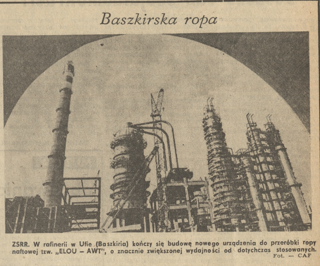
ZSRR. W rafinerii w Ufie (Baskiria) kończy się budowę nowego urządzenia do przeróbki ropy naftowej tzw. „ELOU - AWT”, o znacznie zwiększonej wydajności od dotychczas stosowanych. Fot. — CAF
