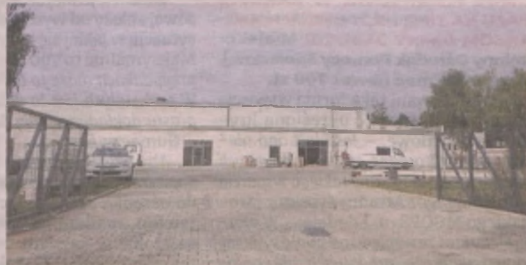
Trwa budowa kolejnej Biedronki w Jarocinie
