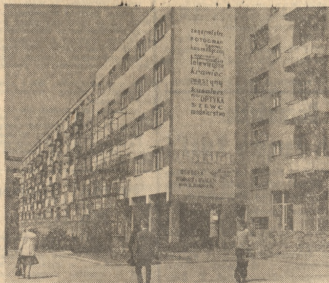
Ściany domów nowego Konina pokrywają reklamy zakładów usługowych. Niestety, świadczeń tych jeszcze wciąż za mało jak na potrzeby 50-tysięcznego miasta. Fot. H. Kamza
